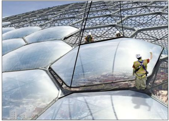
〈투명유리 공사 장면?〉
